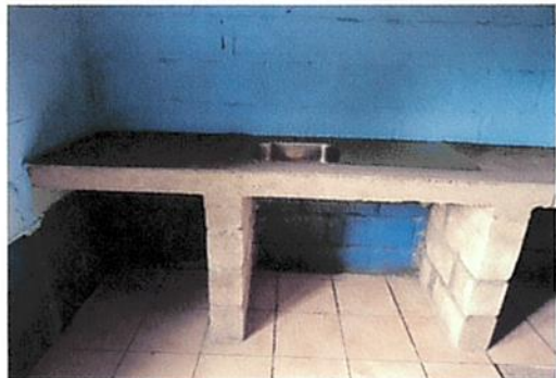
Foto 1: Mejoramiento de cocina, reconstrucción de poyetón, colocación de plancha y chimenea.
