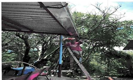
Foto 6: Reparación de canales y bajadas de agua.
