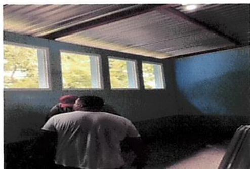
Foto 5: Reparación de columna en el aula.
